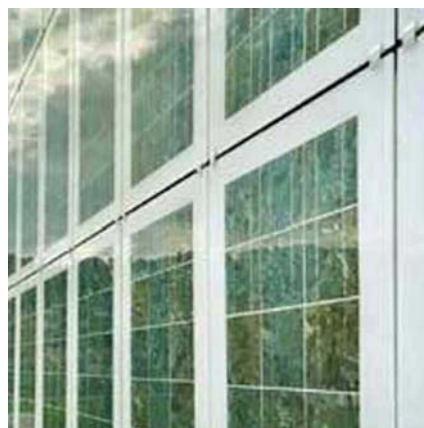
Reihe von Sonnenkollektoren
