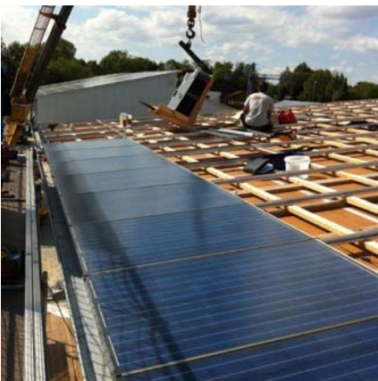
Fixation des modules sur le toit lattes
