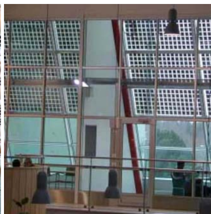
Toit incliné avec panneaux photovoltaïques
