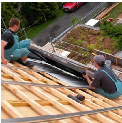
Préparation de toit
