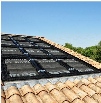
Installazione del sistema di fissaggio
