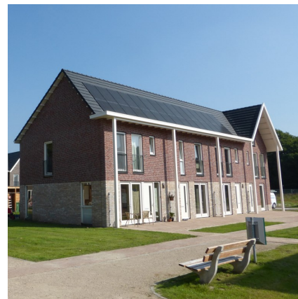
Esempio di installazione completata
