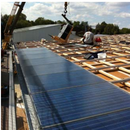
Fissaggio dei moduli sul tetto listelli
