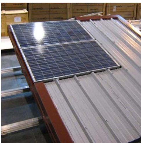
Fissaggio dei moduli sul tetto
