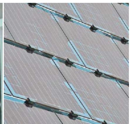
Die Befestigung der Module auf der Fassade
